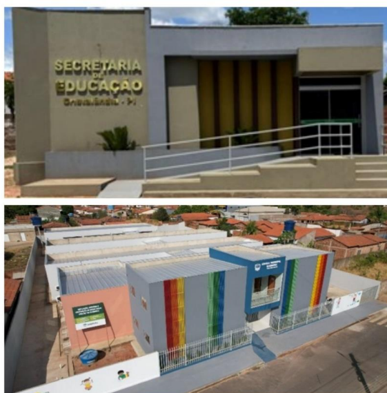
Figura 51 – Nova Sede FME e Ampliação e Reforma da Escola
